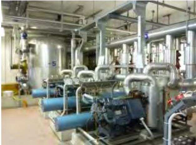
E' stato installato sulla copertura dello stabilimento un altro CIRCUITO -5°C costituito da n° 5 chiller aventi gas refrigerante freon R134A che alimentano alcuni asciugatoi e altri n° 2 chiller necessari per le stagionature dell'ampliamento.
